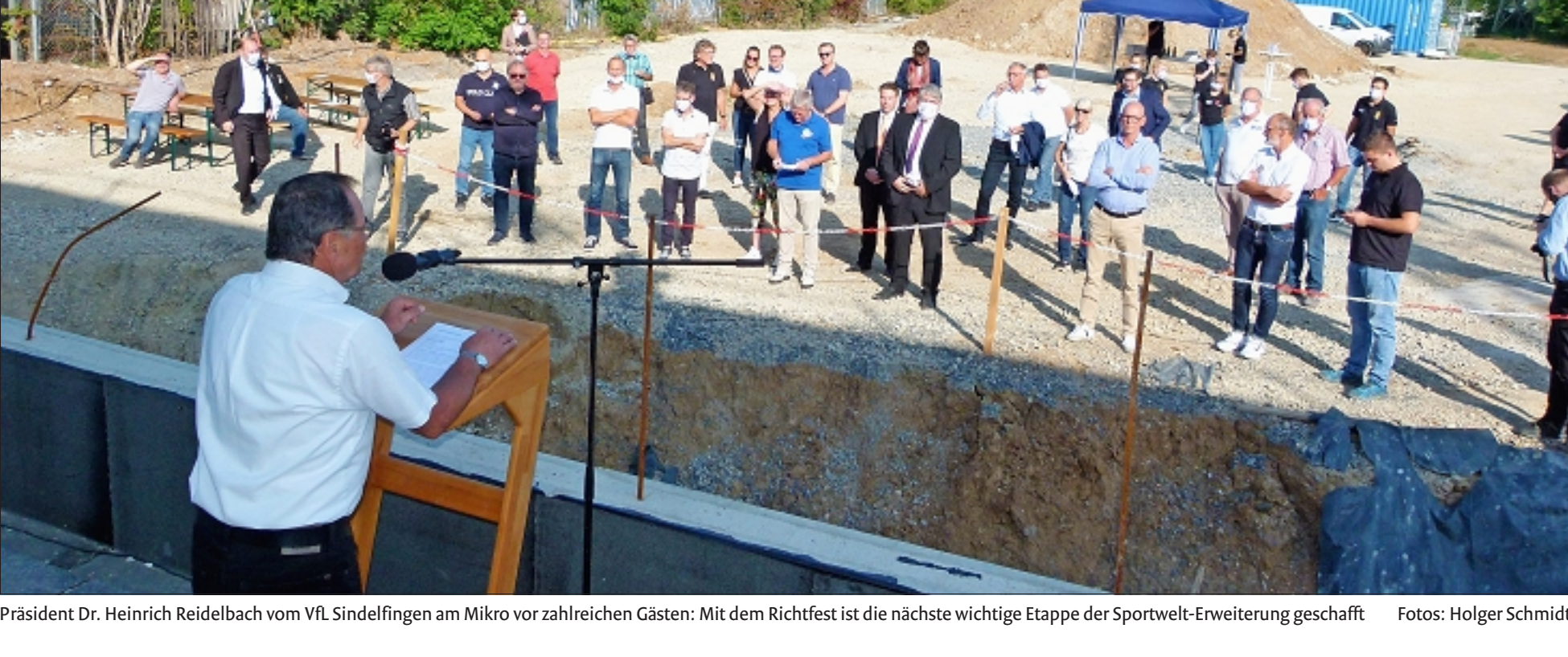
Präsident Dr. Heinrich Reidelbach vom VfL Sindelfingen am Mikro vor zahlreichen Gästen: Mit dem Richtfest ist die nächste wichtige Etappe der Sportwelt-Erweiterung geschafft Fotos: Holger Schmidt
