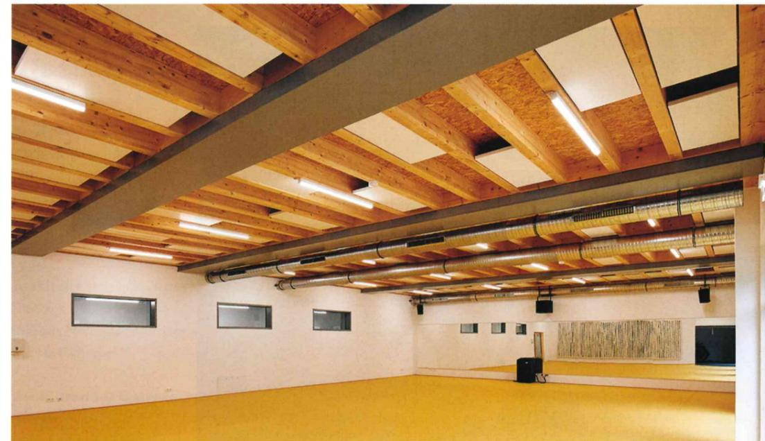
Die Holz-Beton-Verbundbauweise erlaubt große Spannweiten.
